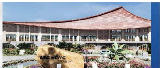
CÔNG TRÌNH RESORT LẠC HỒNG Địa điểm: Lâm Đồng
