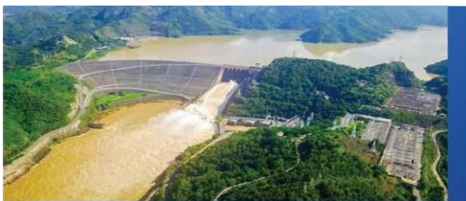
CÔNG TRÌNH THỦY ĐIỆN KON TUM Địa điểm: Kon tum
