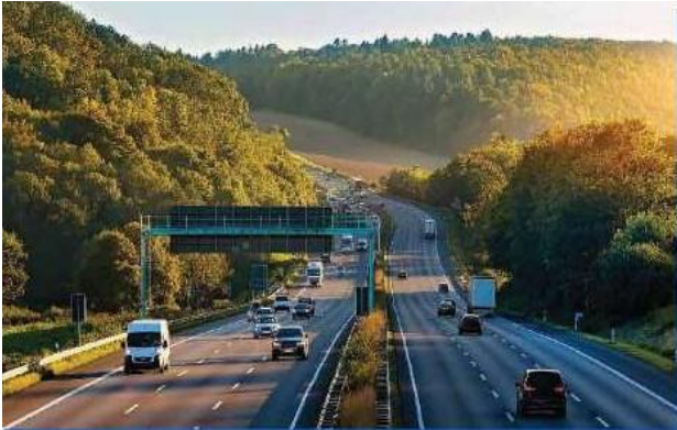
CÔNG TRÌNH XÂY DỰNG ĐẠI LỘ ĐÔNG TÂY Địa điểm: Đak Lak
