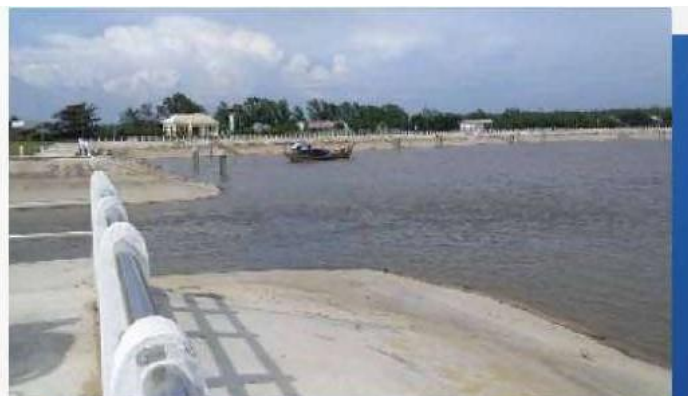
CÔNG TRÌNH BỜ KÈ TRÀ CÚ Địa điểm: Trà Vinh
