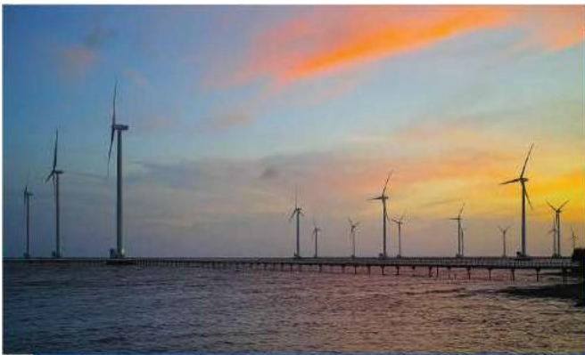
CÔNG TRÌNH ĐIỆN GIÓ BẠC LIÊU Địa điểm: Bạc Liêu
